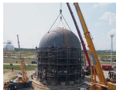
A terméktároló tartály építés közben
