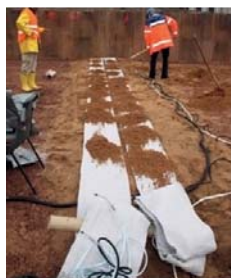
8. ábra. Jeladásra és továbbításra alkalmas innovatív textilszerkezet felépítése és elhelyezése
