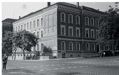
Budapest, II. Lajos utcai Általános Fiúiskola
