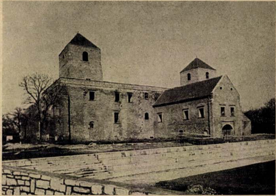
1. ábra. A helyreállítás alatt levő várpalotai vár
