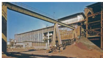
TVM I. SZ. KÉNSAVGYÁR ÉPÍTÉSE
