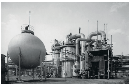
ATMOSZFERIKUS FÖLDGÁZBONTÓ AMMÓNIAGYÁRTÁSHOZ
